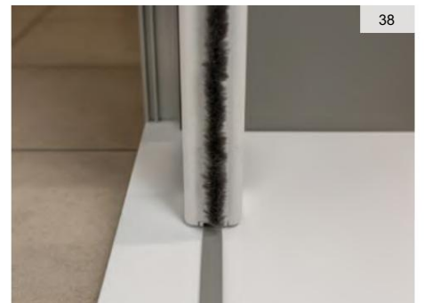
Dégraisser et sécher la surface de fixation avant de coller l'adhésif double face : l'adhésion complète est obtenue au bout d'au moins 24 heures.
