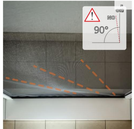
Dévissez jusqu'à ce que le profil horizontal soit en appui léger contre la poignée
