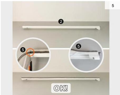
Dégraissier et sécher la surface de fixation avant de coller l'adhésif double face : l'adhésion complète est obtenue au bout d'au moins 24 heures.
