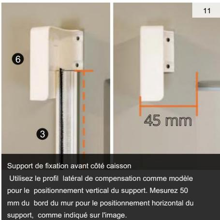
Support de fixation avant côté caisson. Utilisez le profil latéral de compensation comme modèle pour le positionnement vertical du support. Mesurez 50 mm du bord du mur pour le positionnement horizontal du support, comme indiqué sur l'image.
